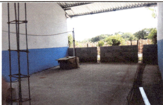
Foto 3: PARTE LATERAL DEL AULA PINTADA EN SU TOTALIDAD
