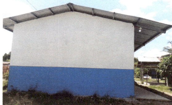
Foto 4: EN LA IMAGEN SE OBSERVA LA PARTE DE LA PINTURA DE FINALIZADA EN LAS PAREDES DEL AULA
